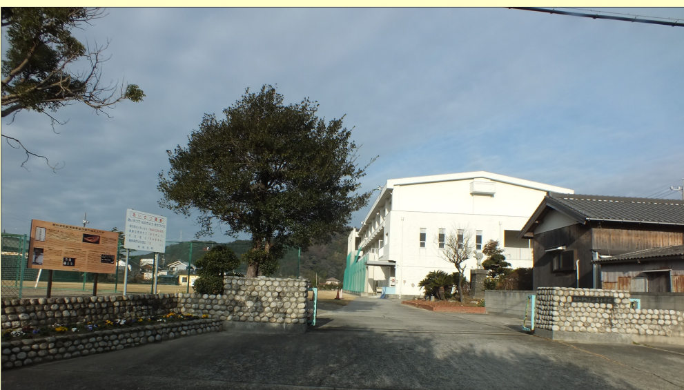
資料未整備で閉館されたままの歴史民俗資料館（旧山海小）
