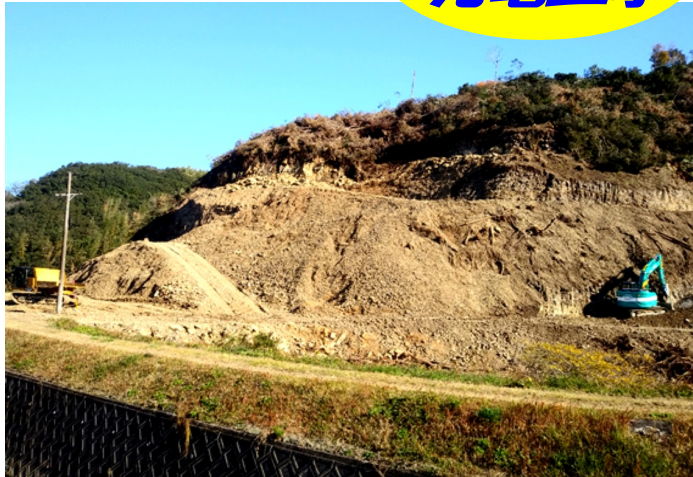
無残に崩されていく内海の道根・道入地区の里山 (2021.12.9)
