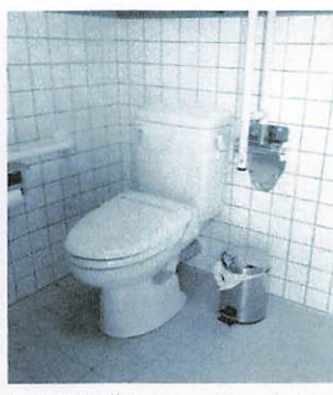
▲設置が進むサニタリーボックス
